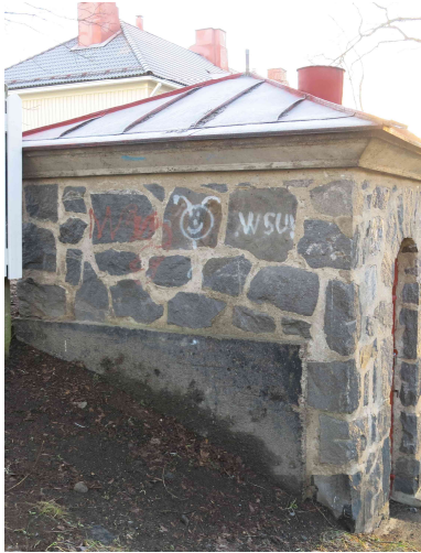
Betoninen suojamuuri maapenkan ja kioskin pohjoisseinän välissä. Kioski lännestä.
