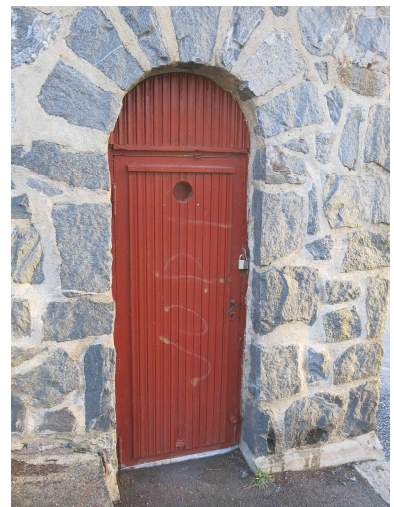
Oven ulkopinnan paneeli on 1950-luvulle tyypillinen.
