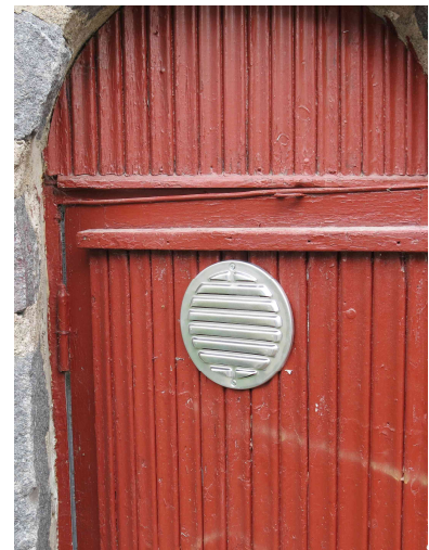
Oven tuloilma-aukon uusi säleikkö.
