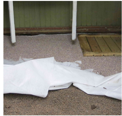
Leca-soraa n. 10 cm, suodatinkangas ja sepeliä n. 5 cm.
