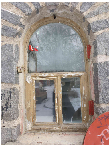
Eteläsivun ikkuna; vasemmalla Peltinen ikkunan suojaluukku.
