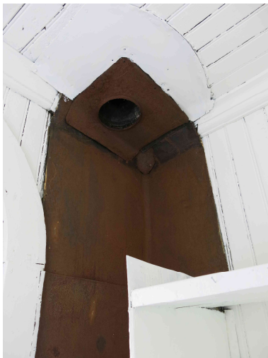
Kamiinan takana olleet pellit muistuttavat lämmitystavasta.
